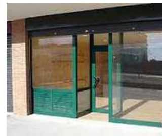
MEJORAS EN INFRAESTRUCTURA
